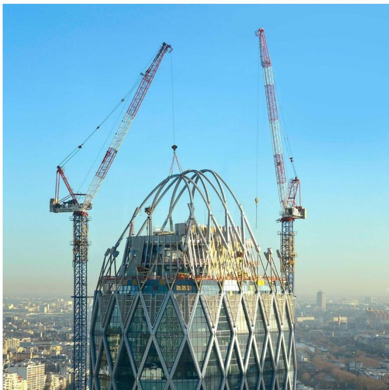
Рисунок 3.3.5 – Кран башенный Liebherr 357 HC-L.
